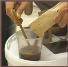
2. Nun rühren Sie den Putz mindestens 5 Minuten mit dem Bohrmaschinenquirl gut durch, bis eine glatte, homogene Masse entsteht. Falls der Putz nach einiger Zeit zu dick wird, können Sie nochmals Wasser beimischen. Die Putzmasse darf nicht auf der Kelle zerfließen, dann hat der Putz die richtige Konsistenz.
