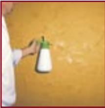
Wenn Sie einen stärkeren Glanzgrad erzielen möchten, dann besprühen Sie die Fläche öfter mit Wasser und verpressen immer wieder mit der Glättkelle die Oberfläche. Weitere Möglichkeiten sind das Verwaschen mit einer Streichbürste oder die gleichmäßige Strukturierung mit der Kelle.
