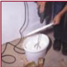
Vor dem Anmischen mit Wasser sollte VENEZIA - am besten mit einem Bohrmaschinenquirl - gut vermischt werden. Auf diese Weise werden die Mineralien in der Wandspachtelmasse gut verteilt. Um übermäßige Staubentwicklung zu vermeiden, schneiden Sie ein kleines Loch in den Eimerdeckel und stecken den Bohrmaschinenquirl durch.
