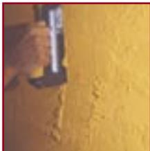
Wenn Sie mit dem Auftragen des Putzes fertig sind, dann können Sie den Putz entweder mit der Schwammscheibe abreiben oder mit der Streichbürste verwaschen. Dies geschieht erst dann, wenn der Putz wieder angezogen hat, aber noch nicht ganz trocken ist (Fingerprobe).
