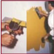
VENEZIA wird mit einer rostfreien Edelstahlkelle aufgezogen. Der Auftrag erfolgt ungleichmäßig, aus verschiedenen Richtungen, mal eher dünn mal etwas dicker. Der Lehmdeputz soll zügig aufgetragen werden, d.h. nicht zu oft und gleichförmig auf einer Stelle spachteln.
