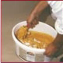
Wenn der Putz gleichmäßig durchgefärbt sein soll, dann müssen die Farb-Pigmente gleich in die Trockenmasse eingerührt werden. Wenn Sie eine lebendige Farbstruktur wünschen, geben Sie das Pigment erst später dazu, und zwar erst nach dem Rühren der Trockenmasse. Dann werden 10 kg VENEZIA mit ca. 3 - 3,5 Liter sauberem Wasser von Hand oder mit Bohrmaschinenquirl angemischt.
